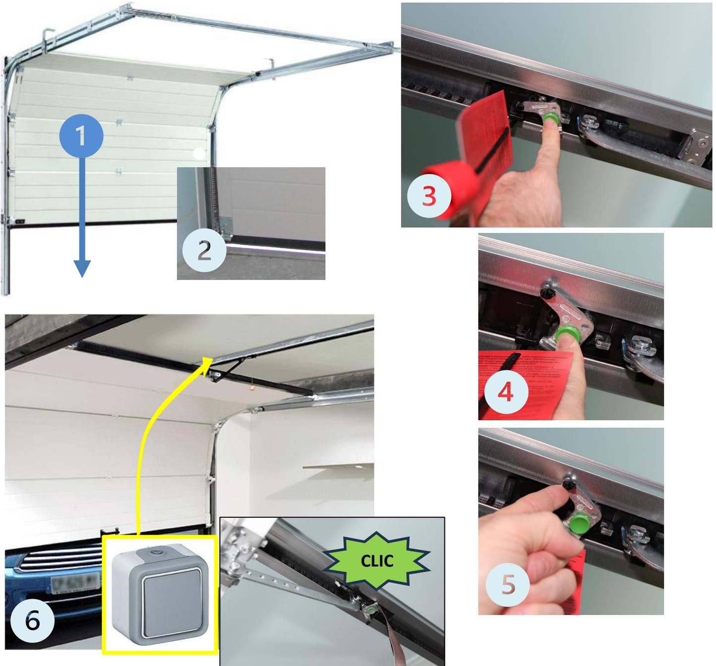
1. Positionner manuellement la porte en position de fermeture ①
